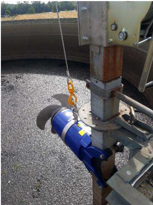
Mise en place d'un agitateur neuf pour le silo
