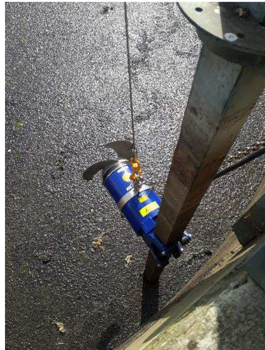
Mise en place d'un agitateur neuf pour le silo
