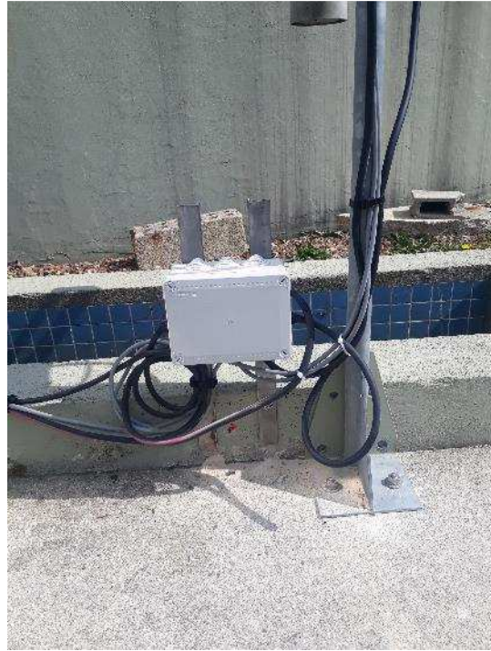
Déplacement de la sonde de mesure eau traitée avec modification de câblage
