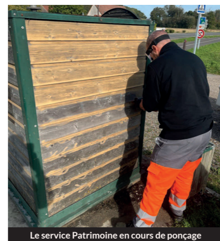
Le service Patrimoine en cours de ponçage
